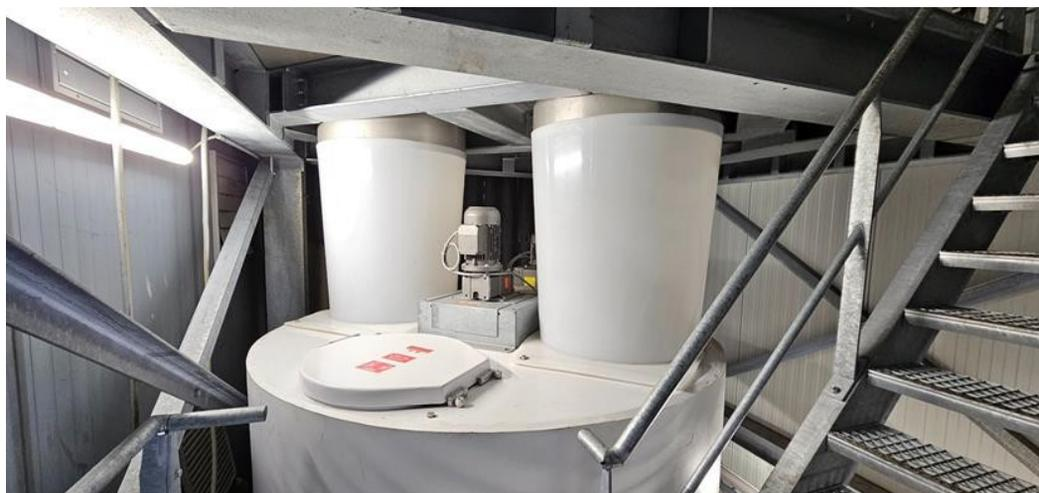
*Dans le silo orbital de Geneglance, la machine à glace écaïlle est située au-dessus de la chambre froide, où une vis maintient la glace en mouvement*
